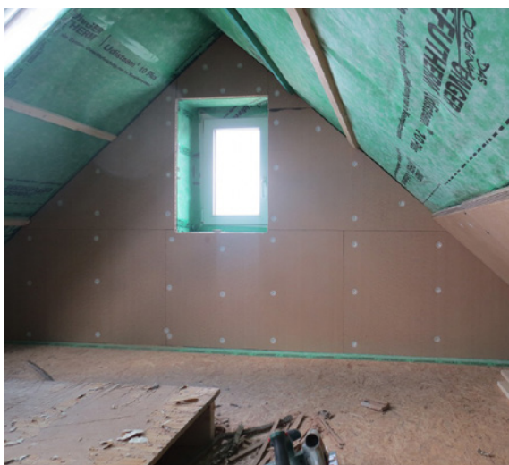
Dachausbau als Untersparrendämmung
