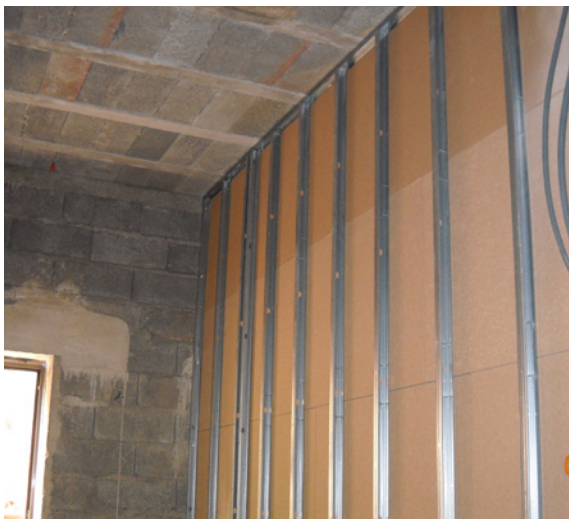
Zwischenwand Ständermontage
