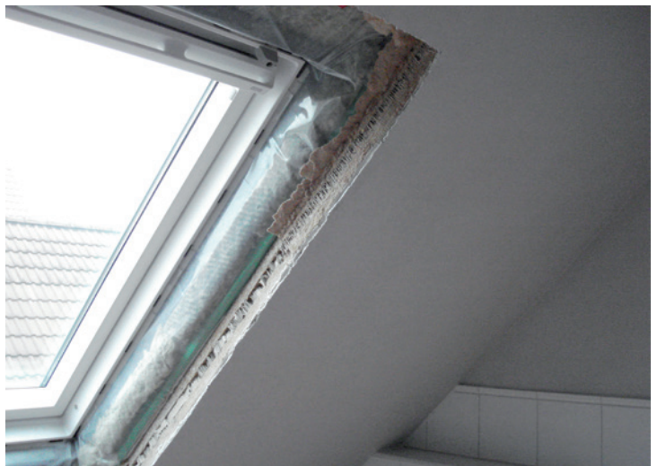
Nachträgliche Dämmung Dachschräge
