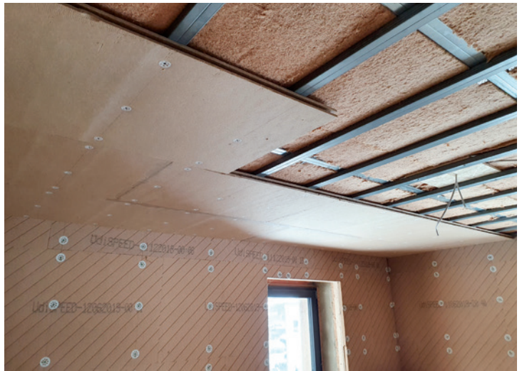
Deckenmontage auf Metallständer
