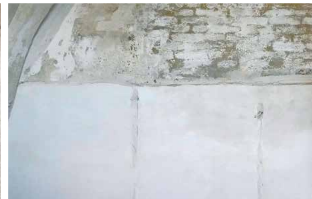
Verhalten des Aerogel Dämmputzes bei stark belasteter Wand: Bild links: Originalzustand vor der Sanierung. Bild rechts: Wärmedämmputz 3 Jahre später
