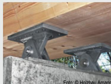
▲ Fußgängerbrücke Freiburg-Ebnet: Schweißkonstruktionen für Auflager und Zuschnitte als Sonderanfertigung
