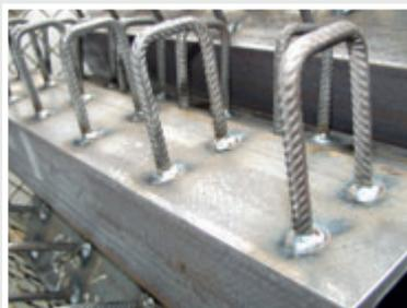
▲ Befestigungswinkel mit Rippentorstahlbügeln
