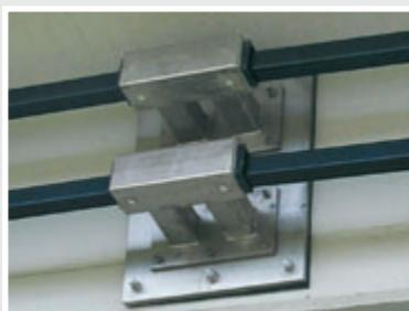
▲ Führungsbefestigungen für Brückenspannkonstruktionen
