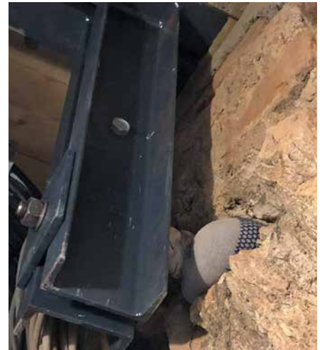
Vollständig verpresstes Ankerstrumpfsystem
