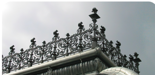
Balkongeländer – Brotteaux in Lyon
