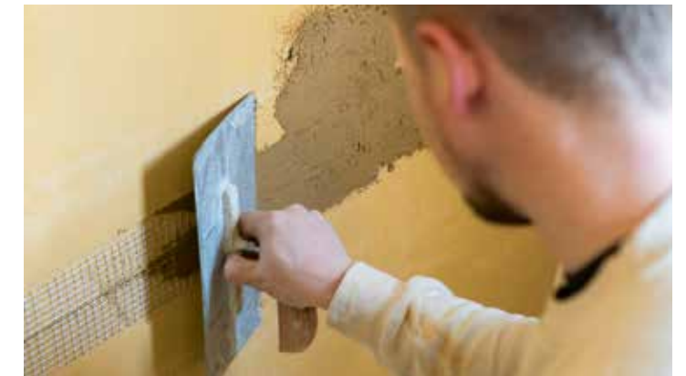
Verspachtelung des Gewebes an den Fugen
