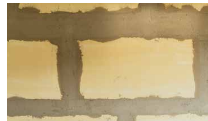
Anschließend werden alle Fugen mit Fugenputz verspachtelt
