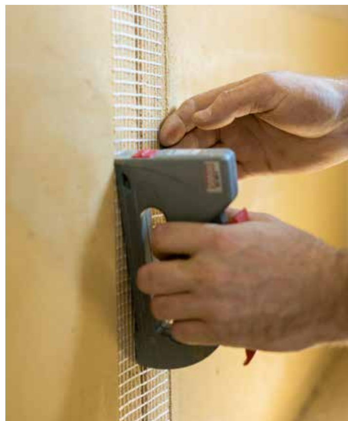
Das Fugenarmierungsgewebe wird über die Plattenstöße getackert
