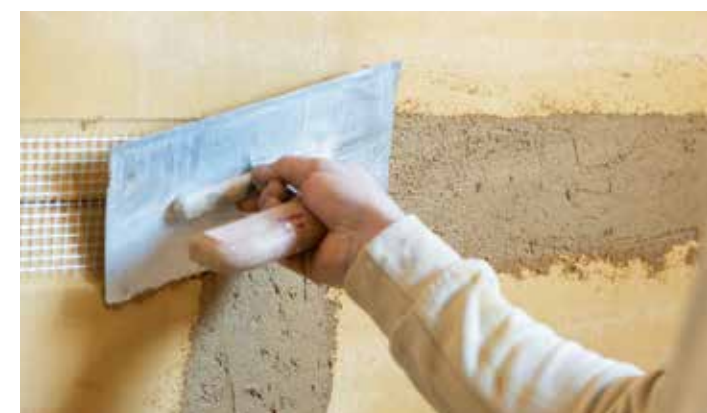
Anschließend werden alle Fugen mit Fugenputz verspachtelt
