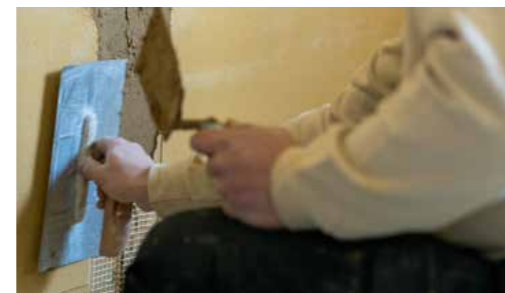
Anschließend werden alle Fugen mit Fugenputz verspachtelt
