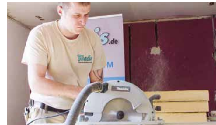
Zuschneiden der Platten
