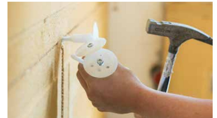
Anschrauben/dübeln der Platten an der Flachkante
