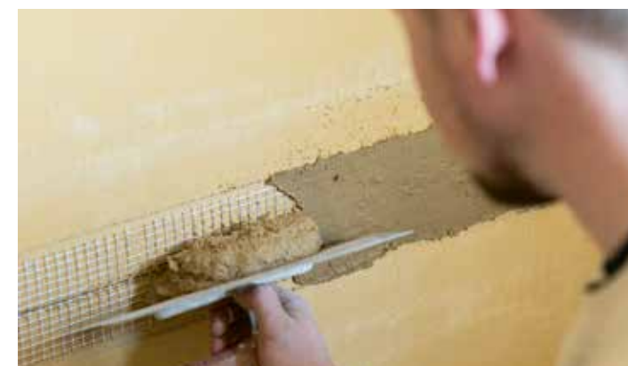
Anschließend werden alle Fugen mit Fugenputz verspachtelt
