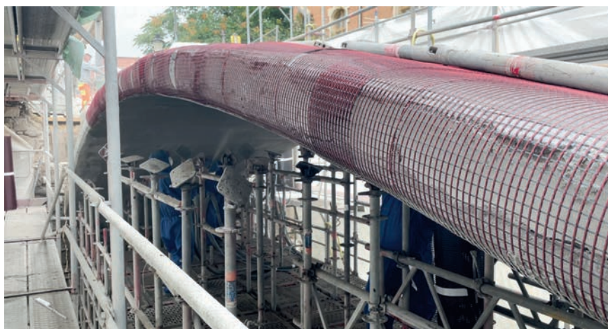
Bild 5 Verstärkungsarbeiten am Brückenbogen der Brücke Thainburg in Naumburg (Saale) Strengthening the arch of the bridge Thainburg in Naumburg (Saale)
