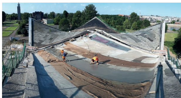
Bild 9 Ausführungsarbeiten mit Carbonbeton Strengthening with carbon reinforced concrete
