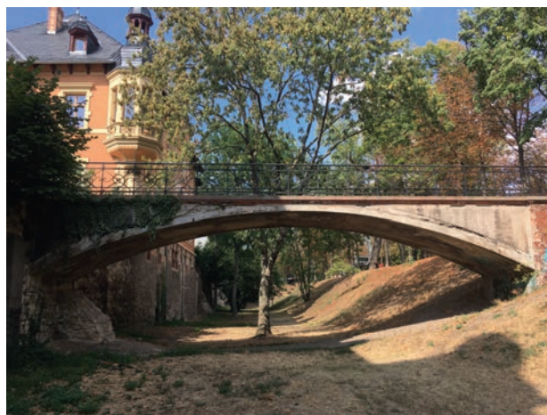
Bild 4 Brücke Thainburg in Naumburg (Saale) Bridge Thainburg in Naumburg (Saale)
