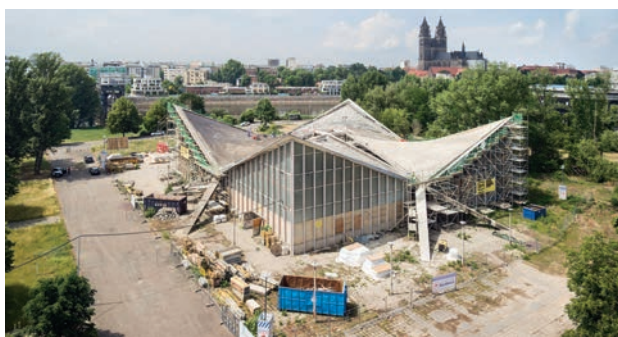
Bild 8 Verstärkung der Hyparschale Magdeburg Strengthening the Hyparshell in Magdeburg
