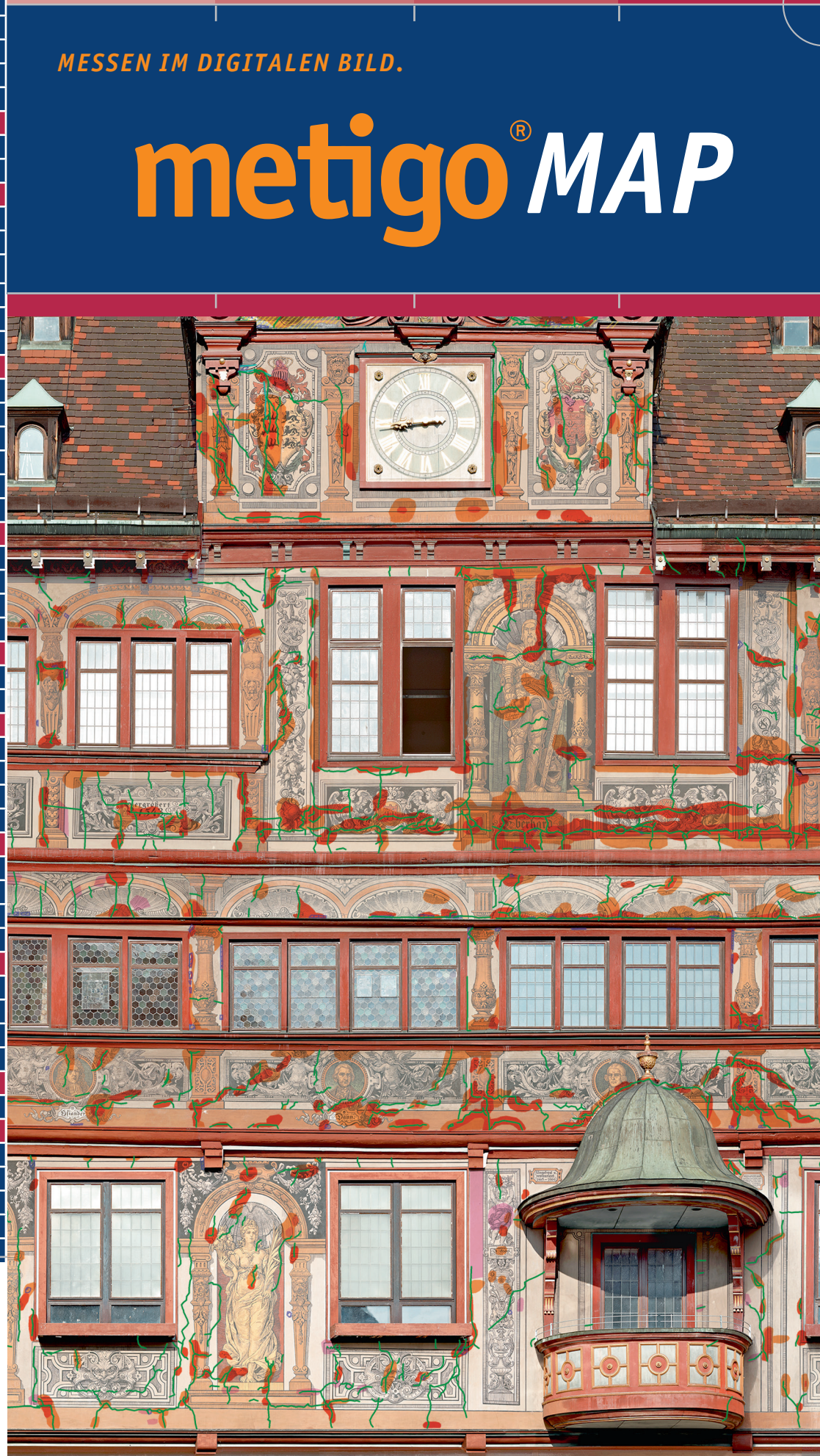
Tübingen, Rathaus am Markt, Ostfassade. Zustandskartierung: Dipl.-Rest. Anja Brodbeck-Holzinger, Tübingen, Stefanie Reting, Stuttgart. Bildplan im Maßstab 1:5, fokus GmbH Leipzig.
