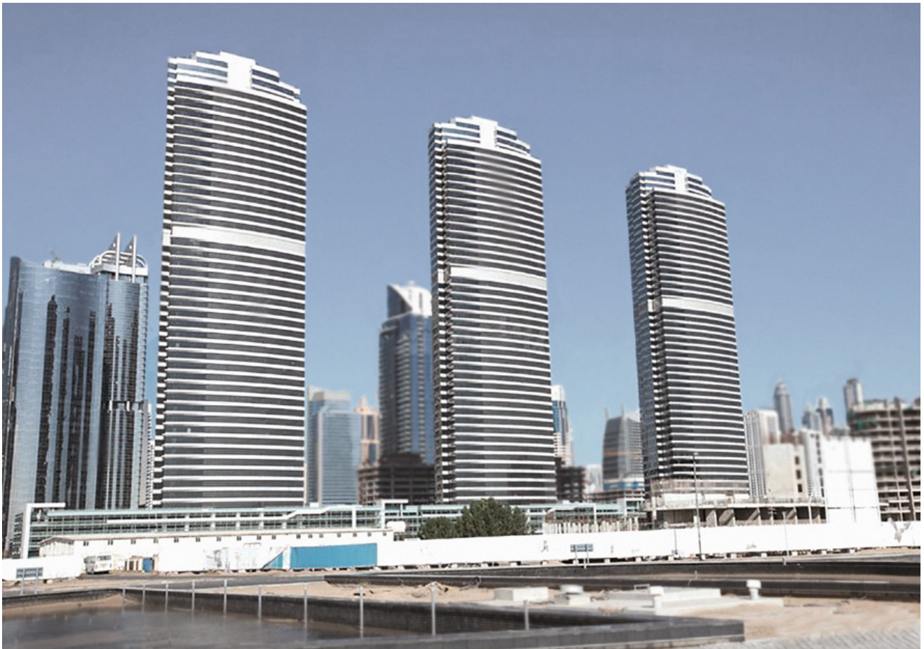
Mazaya Residence in Dubai Für ein Höchstmaß an Sicherheit: Komplette Ausstattung mit 1.200 Notleuchten, abgesichert durch eine batteriegestützte Stromversorgungsanlage.
