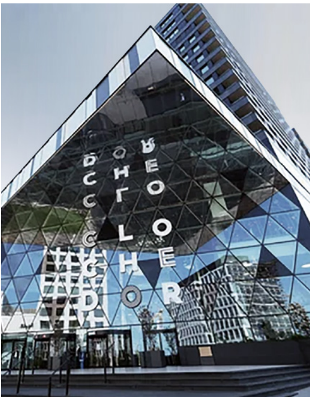
Cloche d'Or in Luxemburg Das hochmoderne, 2019 eröffnete Einkaufszentrum mit 75.000 m 2 Handelsfläche ist mit rund 5.000 RP-Produkten ausgestattet, darunter mehr als 4600 Sicherheitsleuchten und 9 Zentralbatterieanlagen.
