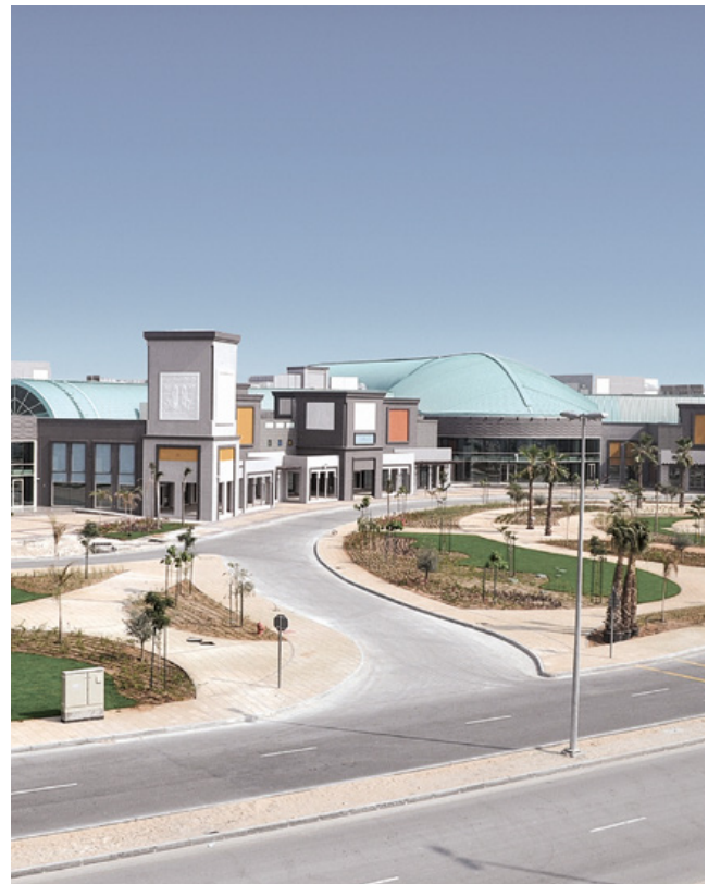
Deira Water Front Market in Dubai Komplette Ausstattung des Fischmarktes mit 2.000 Notleuchten. Die Absicherung erfolgt über eine batteriegestützte Stromversorgungsanlage.
