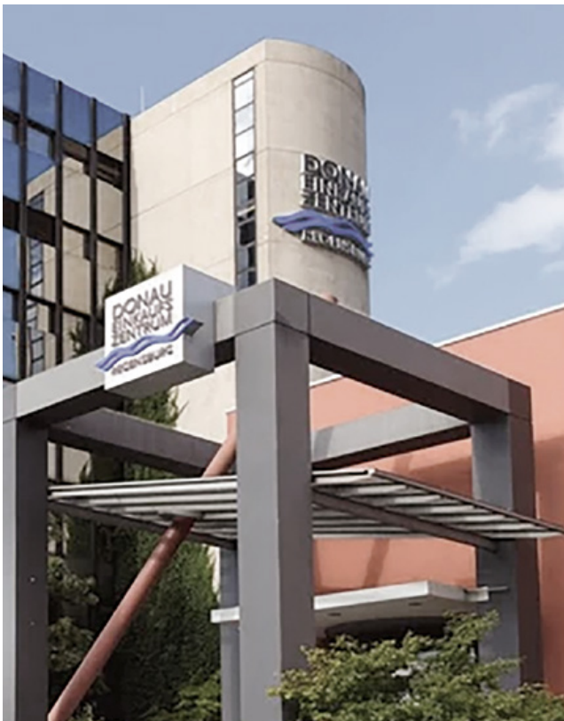
Donau Einkaufszentrum in Regensburg Eins der größten deutschen Einkaufszentren mit 135 Handels- und Dienstleistungsunternehmen auf 82.000 m 2 Nutzfläche. Seit der Modernisierung von 2019 bis 2020 sorgen hier RP-Lösungen mit mehr als 450 Produkten für Sicherheit.
