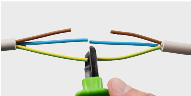
Kabel auftrennen, abmanteln und abisolieren.
