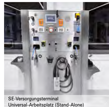
SE-Versorgungsterminal Universal-Arbeitsplatz (Stand-Alone) mit Unterflur-Installation
