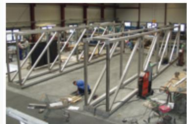
▲ Unterkonstruktion Nordbrücke Minden
