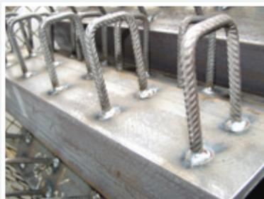
▲ Befestigungswinkel mit Rippentorstahlbügeln
