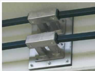
▲ Führungsbefestigungen für Brückenspannkonstruktionen
