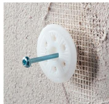
Setzen des Schraubdübel durch das Gewebe
