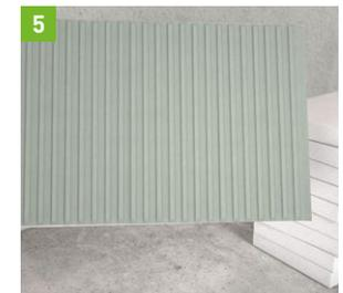
FIX X730 vollflächig auf Entsalzungsplatte auftragen.
