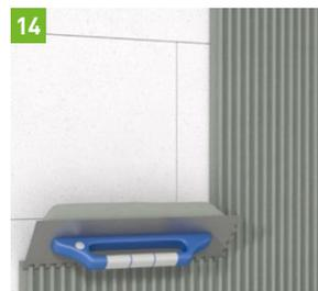
FIX X730 mit 12-mm-Zahntraufel 5 mm dick auftragen.
